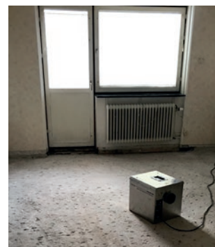
Vid en renovering av vattenskada står ofta en byggfläkt och brummar dygnet runt.
